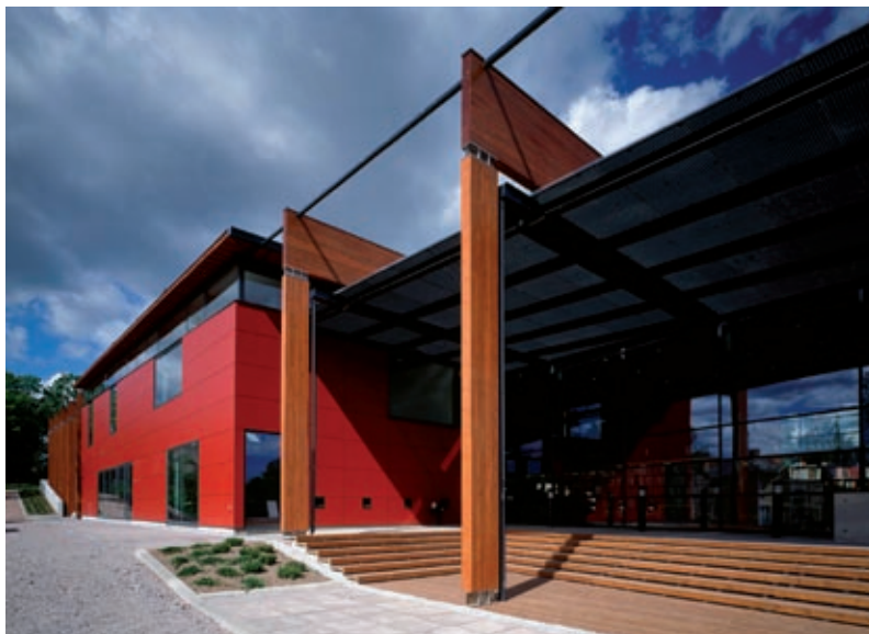
▲ Borgå stadsbibliotek, huvudbiblioteket. Biblioteket invigdes 5.2.2000 och utnyttjar ca 3000 kvadratmeter. Fasaden i lärkträd gör att byggnaden smälter in i den omgivande trästadsmiljön. Speciellt för byggnaden är den promenadväg genom huset som gör det möjligt för stadsborna att ta en genväg över tomten. Foto: Borgå stadsbibliotek.
